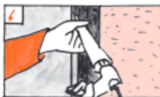
6. Après la pose de la première plaque, appliquez sur le champ un cordon de colle à joint, puis rapportez la seconde plaque en prenant soin de bien écraser le cordon de colle...
